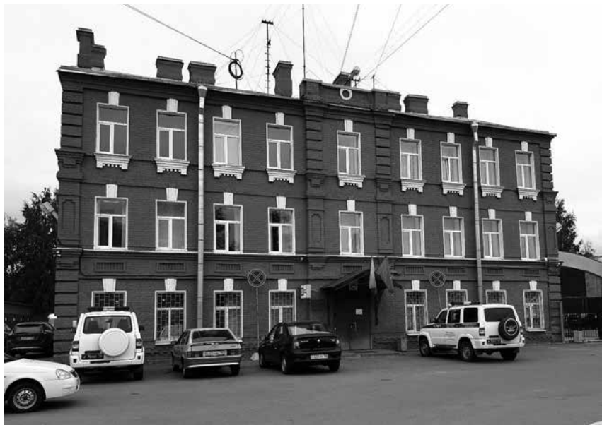
Здание служащих. Ириновский пр., 46
