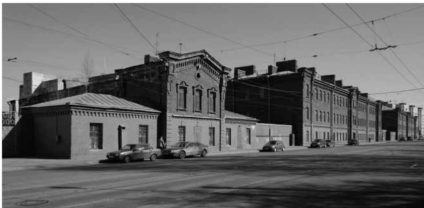
Казармы Новочеркасского полка. Новочеркасский пр., 4
