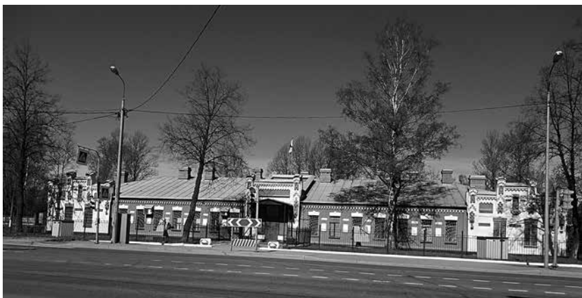
Здание штаба Морского артиллерийского полигона Рябовское шоссе, 130
